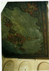
شماره عکس: سقف قاشق اتاق نماز
