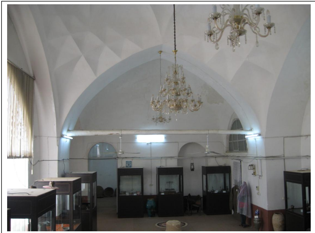
چوب به کار گرفته شده بین طاقها برای استحکام بیشتر
