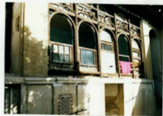
شرح عکس: نمای بیرونی ضلع عربی
