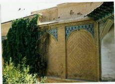
شرح عکس: بدنه آجرکاری و کاشیکاری ضلع شرقی
