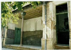
شرح عکس: قسمت از نمای جنوبی
