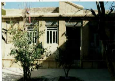
شماره عکس: نمای بیرونی ضلع شمالی
