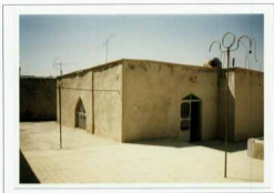
تصویر 1- نمای کلی بناي مسجد آقا مراد ديد از شمال، فهان-1
